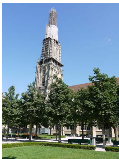
大聖堂の尖塔 修理工事中だった。
